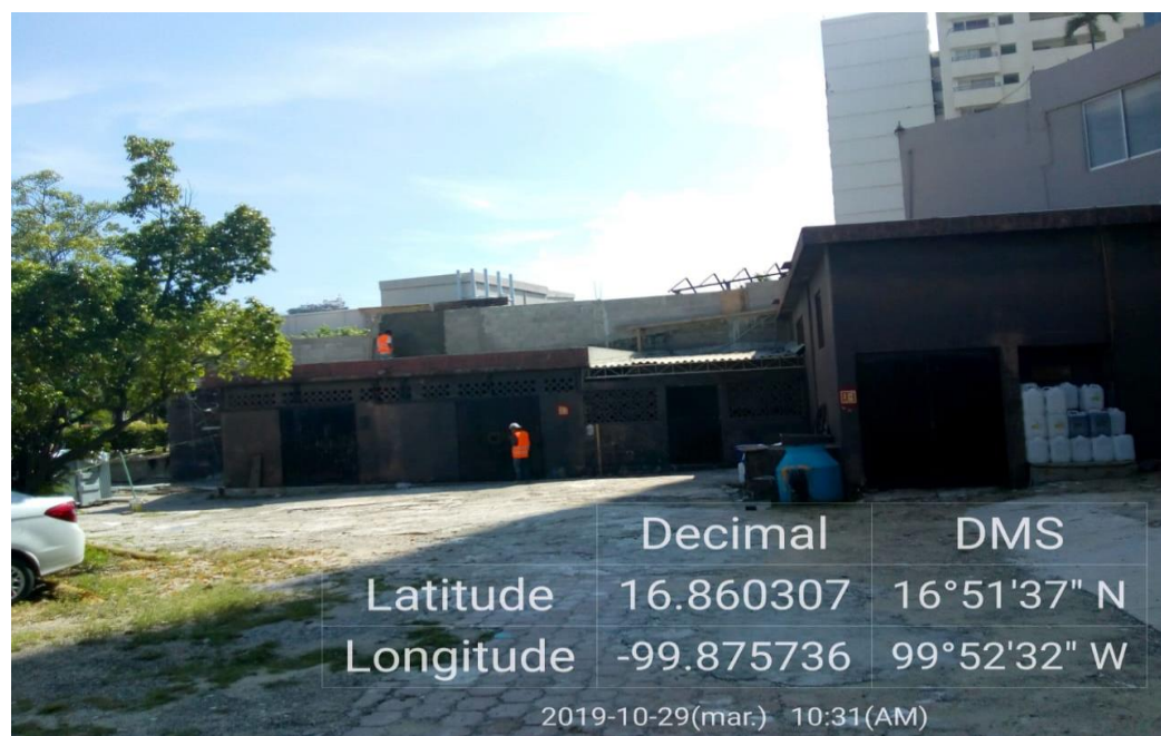
FOTO 2; Preparación del sitio en la etapa 1, bodegas y techado a demoler.
