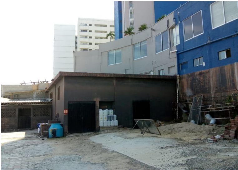
FOTO 4; Una de las bodegas a demoler.
