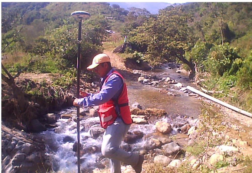
Imagen 33. Levantamiento topográfico en la zona de proyección del puente vehicular.
