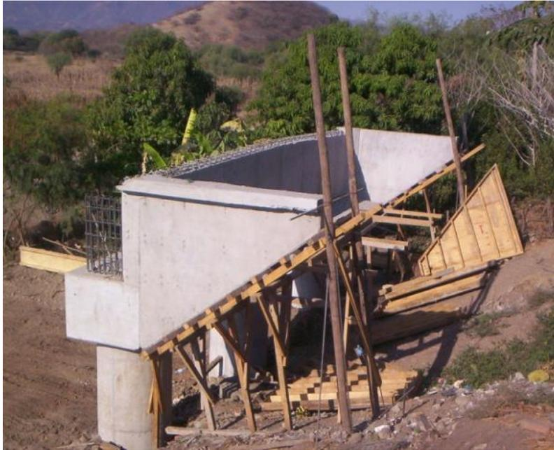
**Ilustración 31** - Ejemplo.: Construcción de estribos y caballetes, sobre un puente
