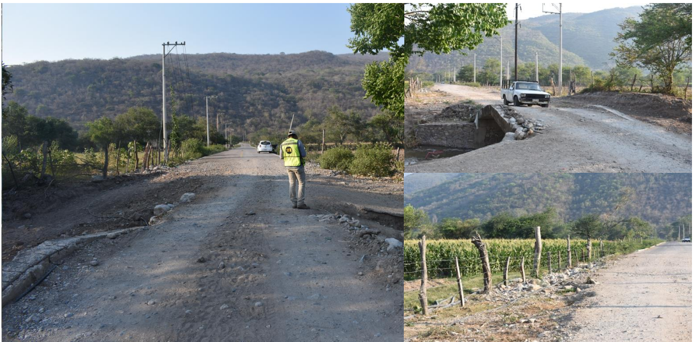
Fotografía 16. Vista frontal del vado existente a base de mampostería.
