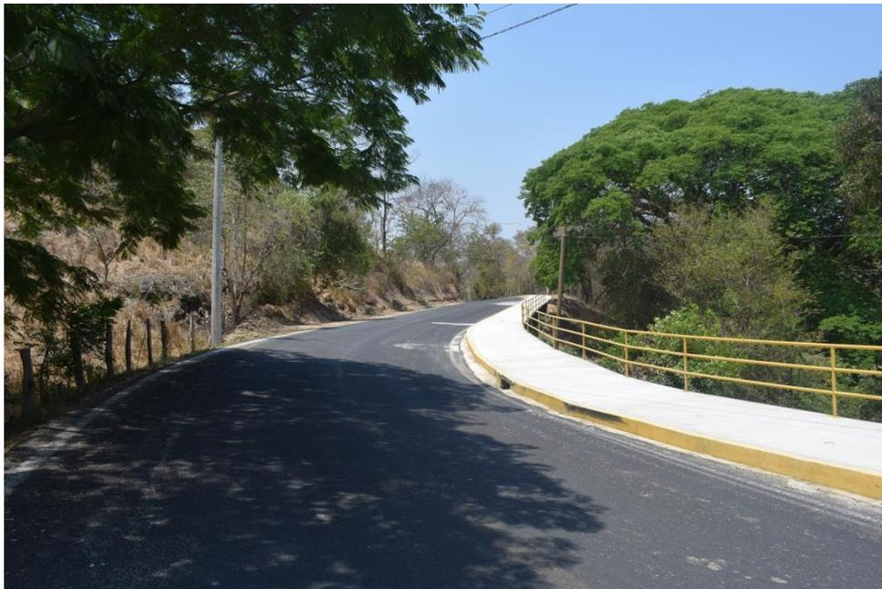
*Fotografía 17. Vista frontal del Km 0+840, en el cual se puede apreciar ancho de corona superior a los 7 metros con desgaste y disgregación sobre la carpeta asfáltica, nótese los árboles aislados ubicados dentro de los corrales colindantes al área ampliarse para el proyecto.*
