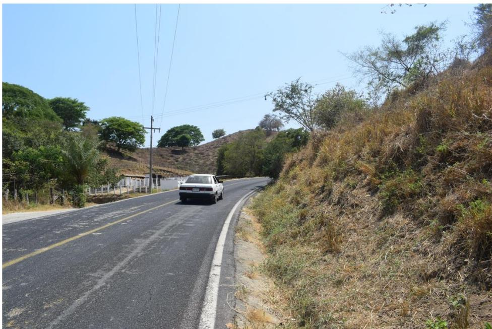
*Fotografía 16. Vista frontal del Km 0+680, en el cual se puede apreciar el ancho de corona de 7 metros de la carretera existente; nótese como en ambos laterales de la carretera no existe vegetación forestal primaria solo dominancia de hierbas y arbustos.*
