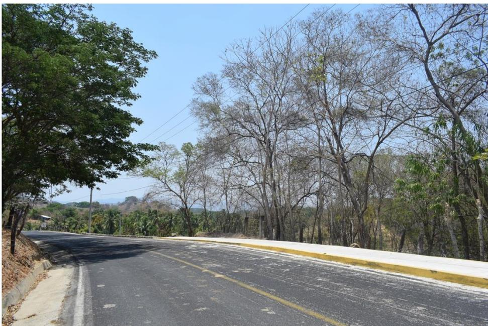
*Fotografía 18. Vista frontal del Km 1+160, en el cual se puede apreciar la disgregación de carpeta asfáltica y el ancho de corona superior a los 7 metros; nótese los árboles aislados ubicados dentro de los corrales en ambos laterales colindantes al área ampliarse para el proyecto.*
