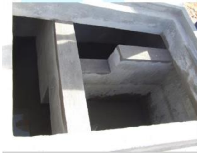
Figura 4.- Ejemplo de la construcción de la Planta de tratamiento a base de concreto.
