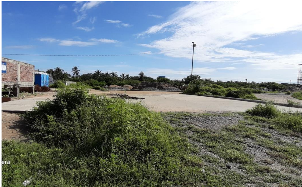
Fotografía 7.- Plancha de concreto, la cual será removida para realizar las actividades constructivas.
