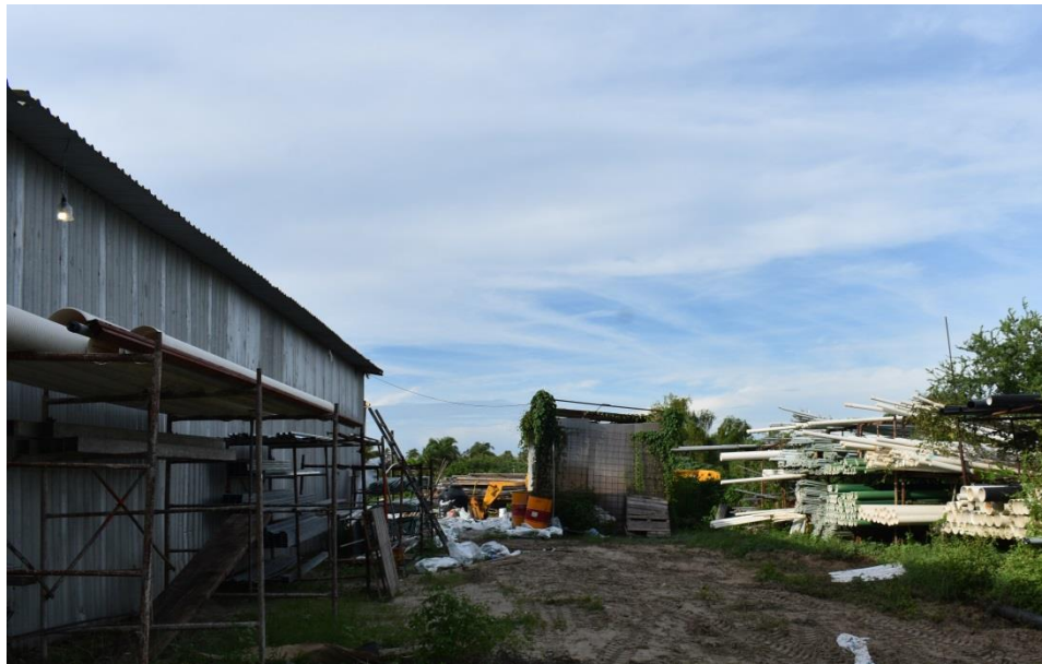
Fotografía 8.- Almacén que se encuentra en el predio desde el año 2009 y será desmantelado.
