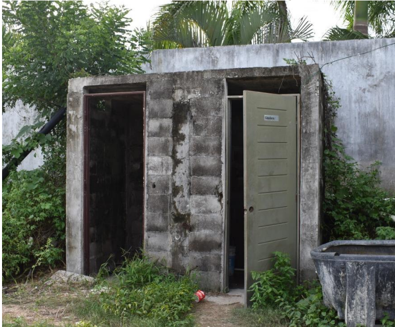
Fotografía 5.- En el predio se encuentran sanitarios, mismos que serán eliminados, para poder construir las obras del proyecto.
