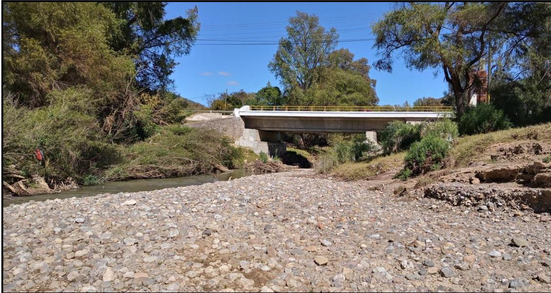
Fotografía 10. Infraestructura hidráulica intermedia entre los dos bancos, ubicada a más de 200 m aguas arriba y aguas abajo como lo establece los lineamientos de la CONAGUA.
