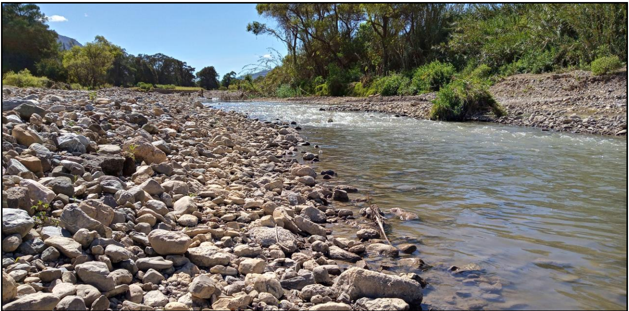
Fotografía 8. La ejecución del proyecto permitirá el encauzamiento del río Mixteco, nótese en la margen izquierda las afectaciones que han sufrido los predios en años anteriores a causa de la creciente del río.
