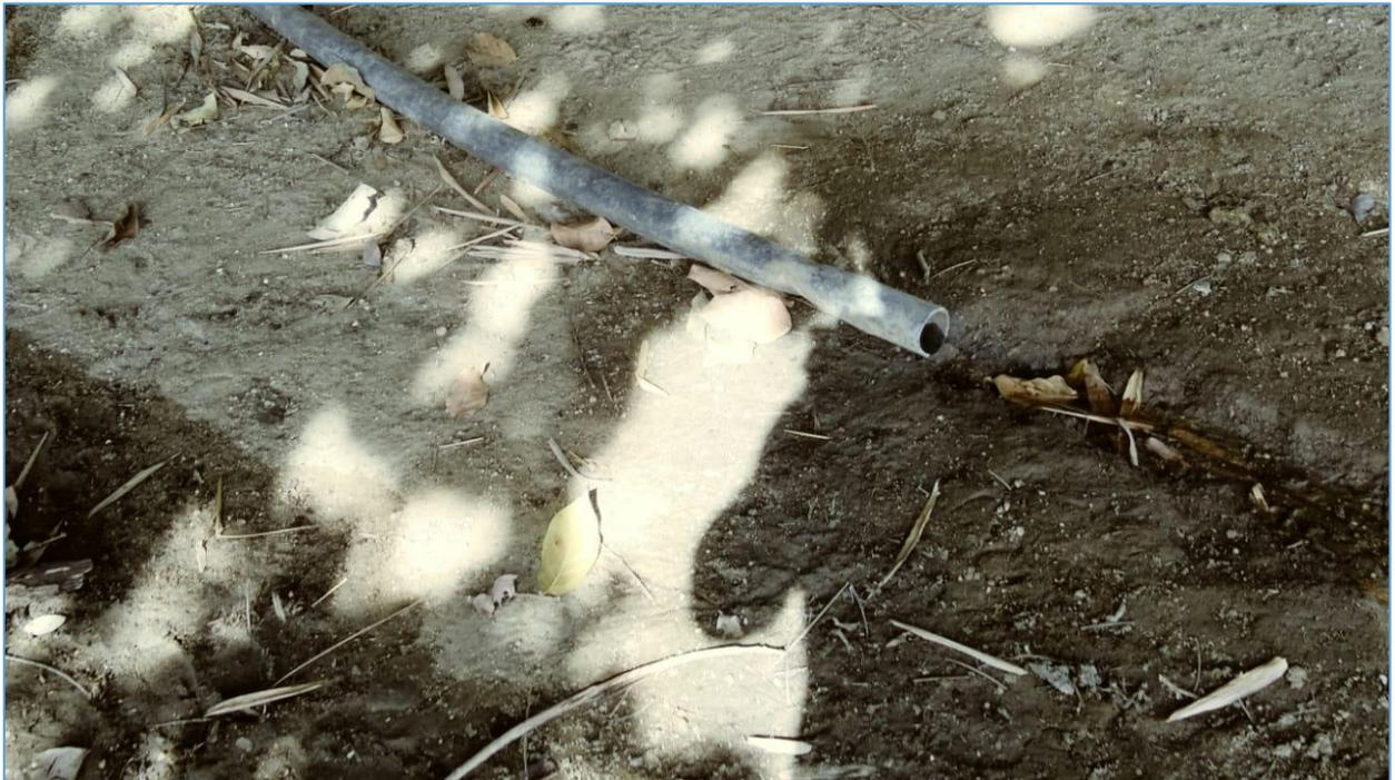
**Ilustración II-23 Presencia de tubos de descarga directa hacia la laguna**
