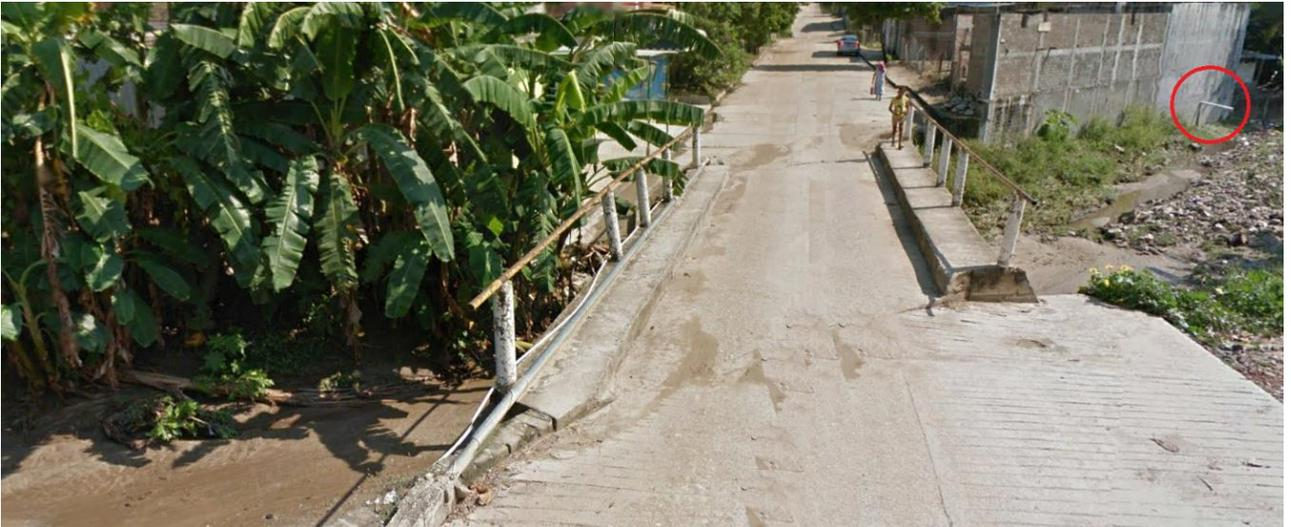
Ilustración II-2 Red de drenaje cruce UNO en arroyo Seco en las coordenadas UTM zona 14 Unidades Metros Datum WGS84, X = 705765.83 m E y en Y= 1757078.79 m N en la calle Vicente Guerrero nótese en la imagen resaltada en círculo rojo la tubería que vierte aguas residuales de forma directa.
