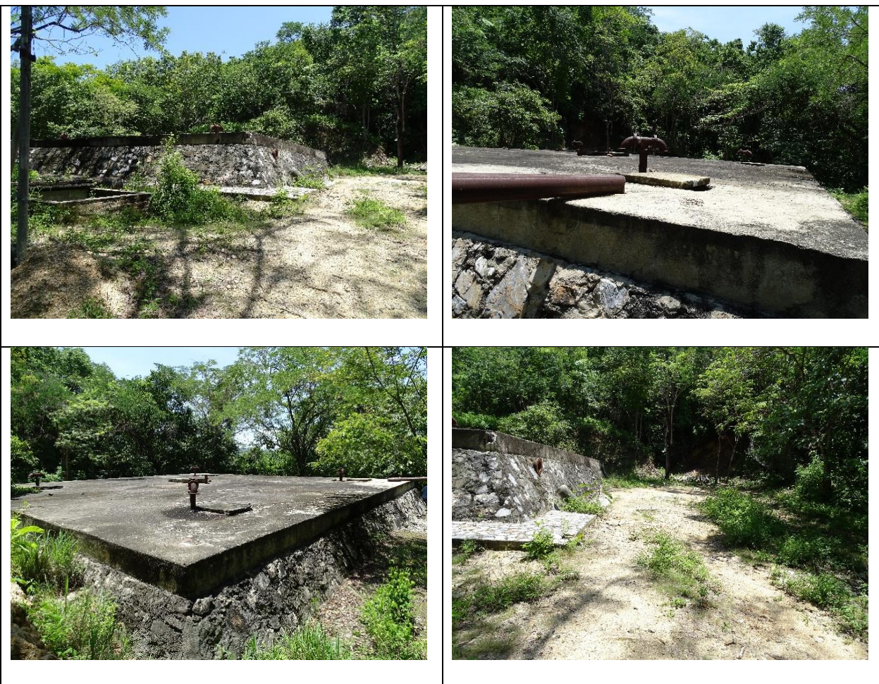
Fotografías del tanque de almacenamiento o Tanque 500 (obra ya existente)
