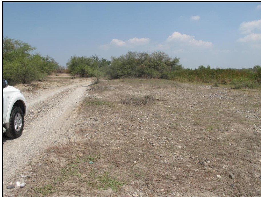
Fotografía 7. El camino de acceso existente será revestido con material del banco en temporada de lluvias para facilitar el rodamiento de los vehículos de carga.
