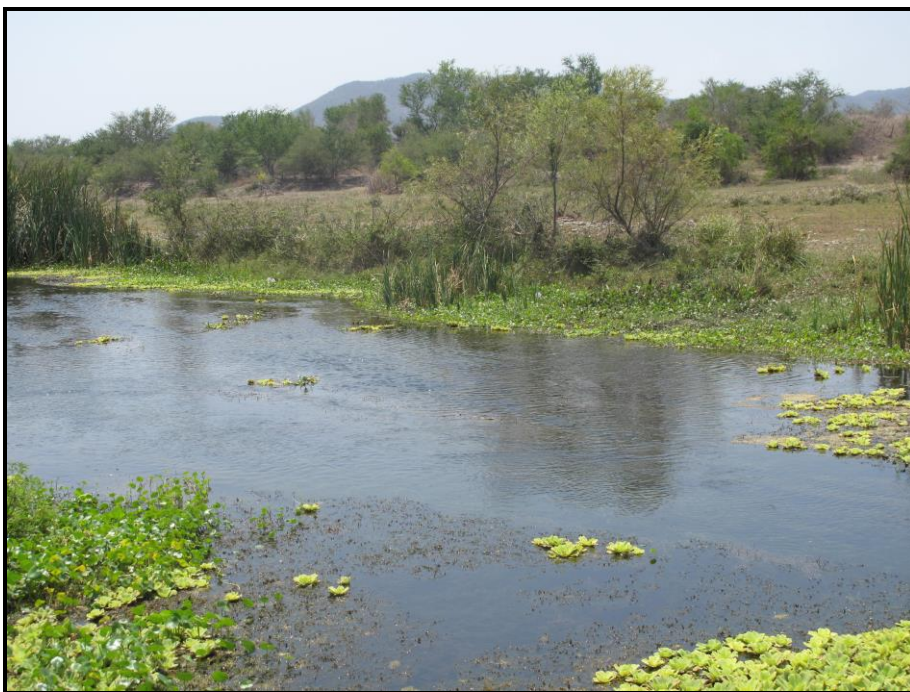
Fotografía 17. El rio Tehuantepec, no presenta bordes en las márgenes, lo que generaría una afectación considerable a predios aledaños en temporadas de lluvia en caso de desbordamiento.
