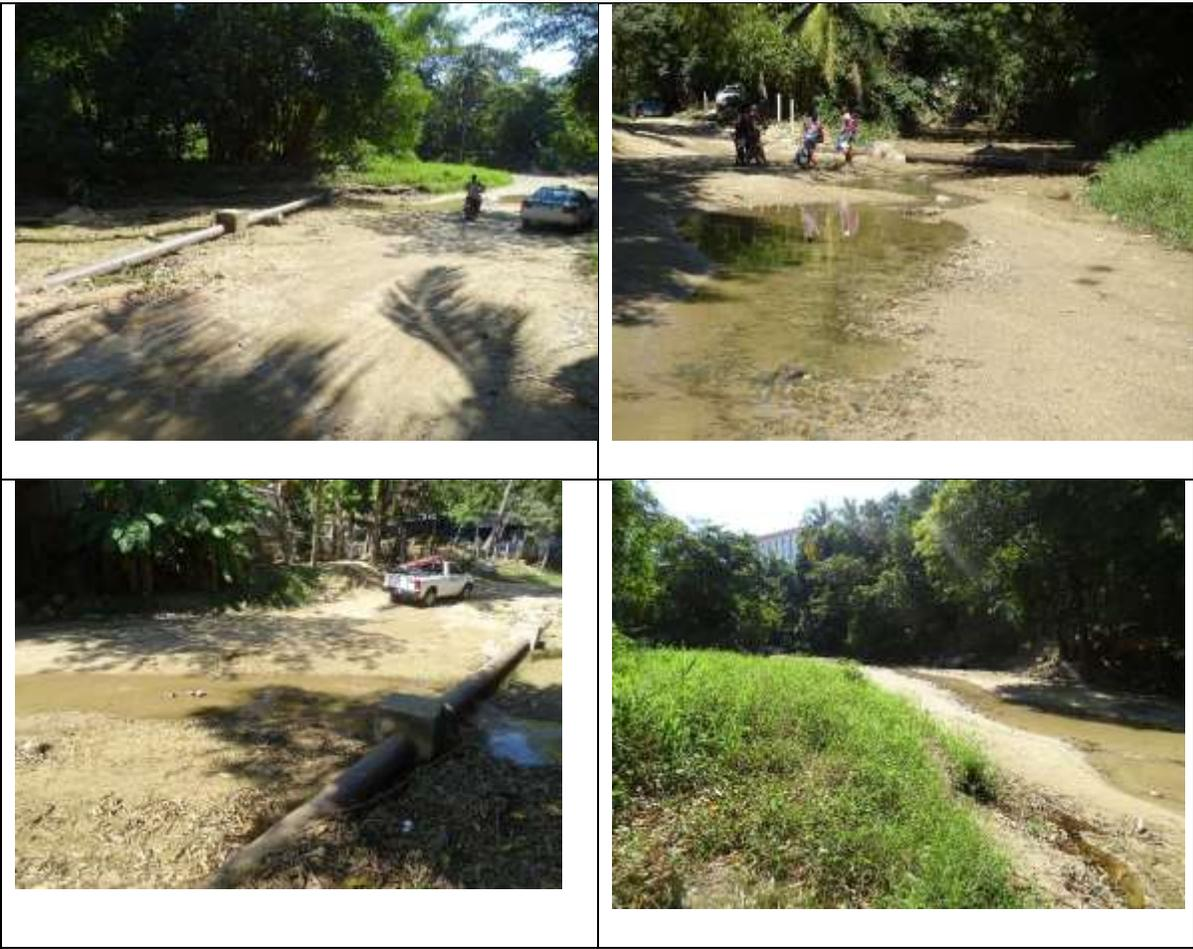
Fotografías donde será necesario la instalación de atraques de concreto, con la finalidad de evitar afectaciones a la línea de conducción a establecer, notese que ya existe la presencia de una línea que de igual manera cuenta con sus atraques.
