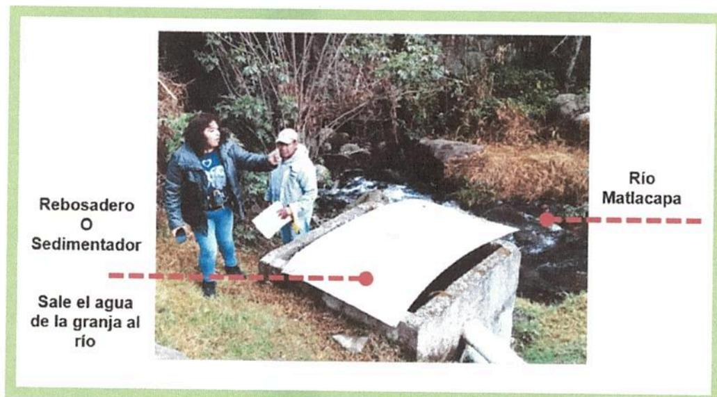
**Figura II.2.1.4.** El agua que sale de la granja pasa a un sedimentador previo a la descarga de las aguas residuales al río o al arroyo. En la imagen se logra ver a la Ingeniero Beatriz supervisor de PROFEPA y al Rep. Legal C. Enrique supervisando las granjas que están operando desde el año 2000.
