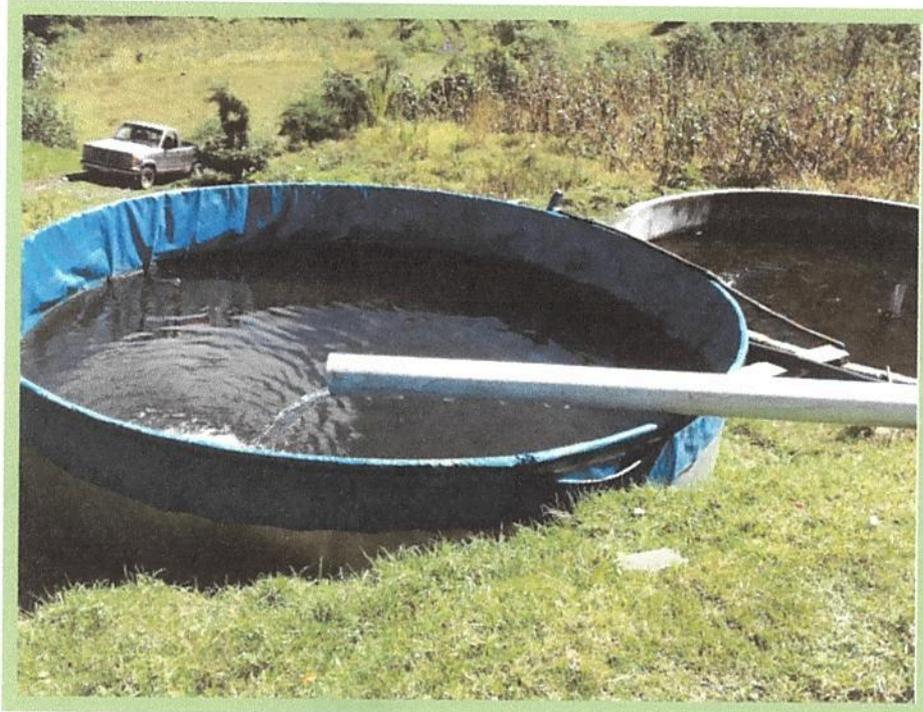
Figura II.1.1.1. Instalación de tanque de lámina con plástico de polietileno sobre la base del suelo
