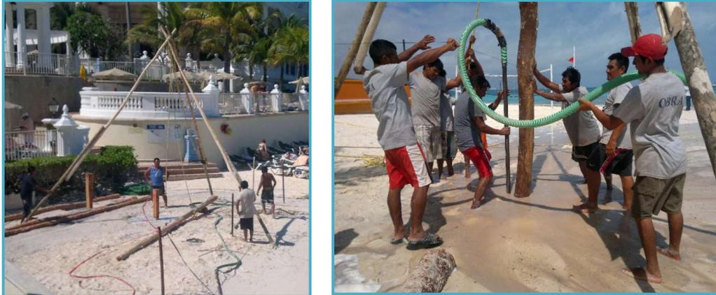
**Figura II\_21. Proceso de chifoneo y colocación de pilotes de soporte.**
