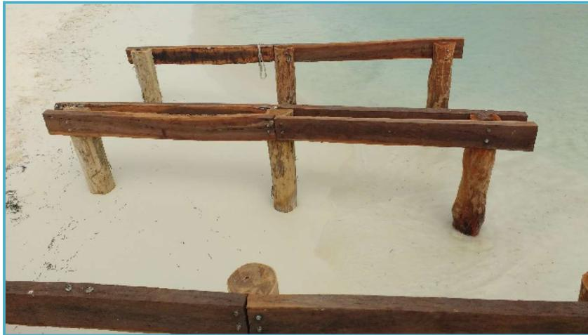
Figura II\_22. Estructura de soporte de la cubierta de palapas y gazebos
