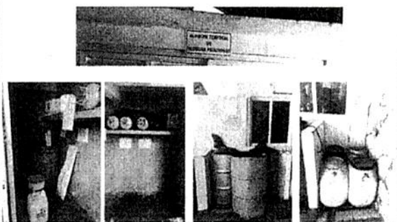
Cámara de Residuos Peligrosos
