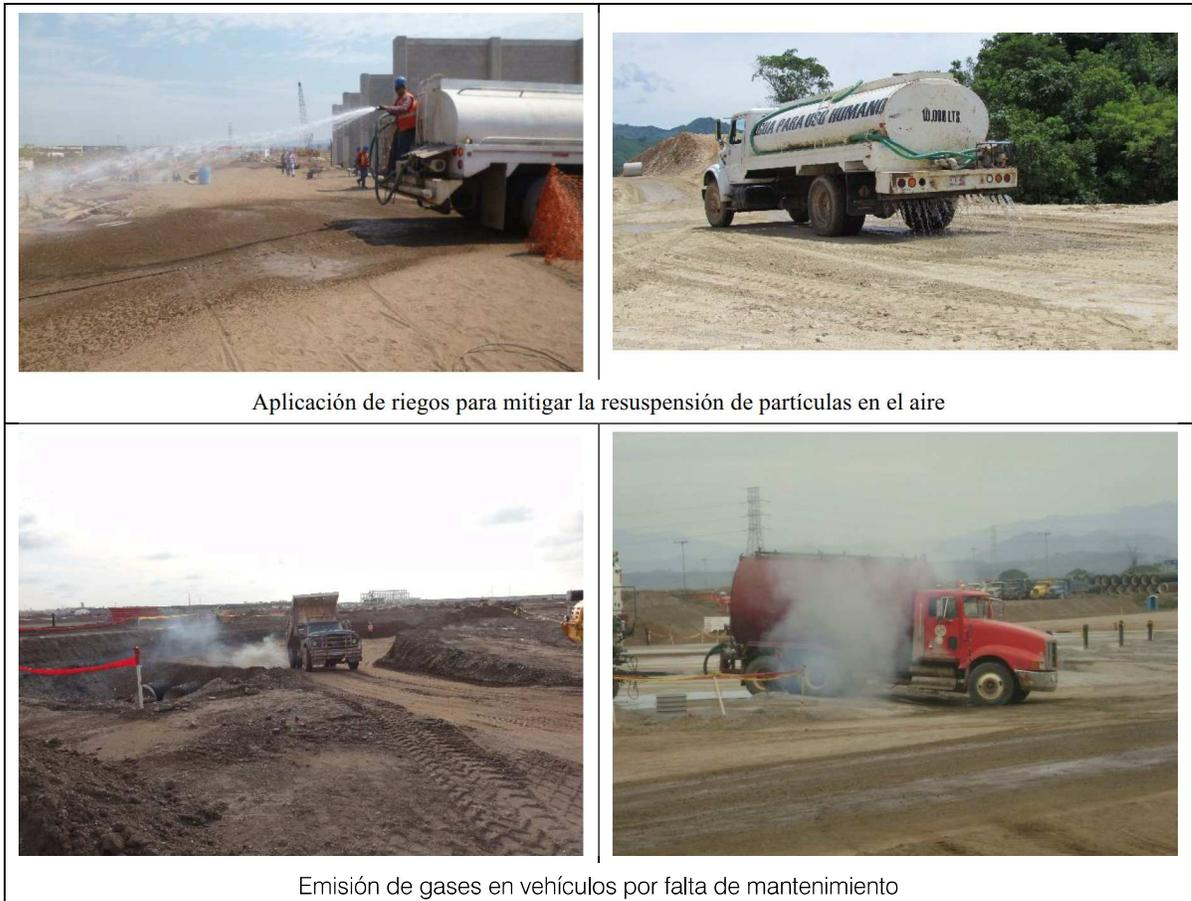
Figura II-11. Ejemplo de afectaciones ambientales y las medidas a implementar para mitigarlas durante las etapas de preparación del sitio y construcción del proyecto.
