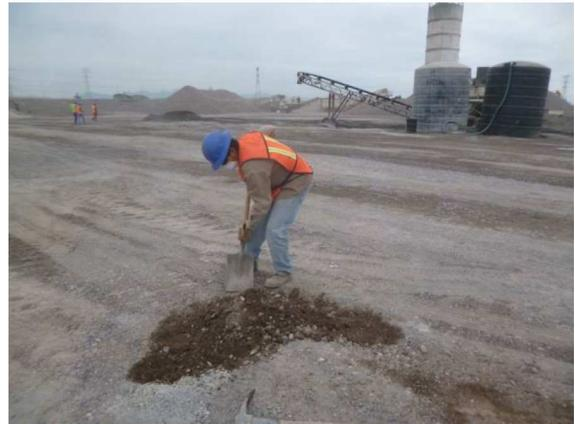
Recolección de suelo contaminado por derrame de hidrocarburos para disposición en el almacén temporal de residuos peligrosos
