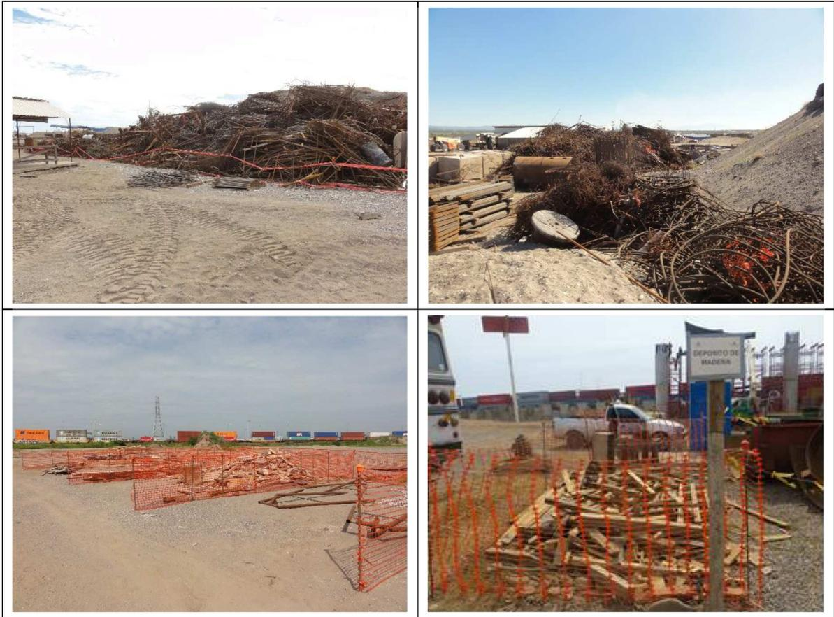
Figura II-15. Ejemplo de la habilitación y señalización de áreas para la disposición temporal de residuos de manejo especial durante la etapa de construcción.
