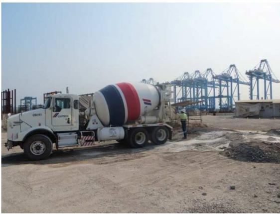
Contaminación de suelo por derrame de concreto durante el colado.
