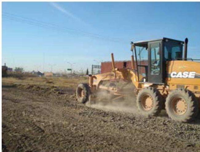
**Figura 2.10.-** ejemplo de trabajo de desmante y mejoramiento para dejar lista el área para el proceso constructivo.
