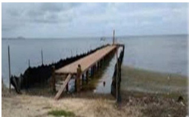
Figura 14. Ejemplo de colocacion de malla
