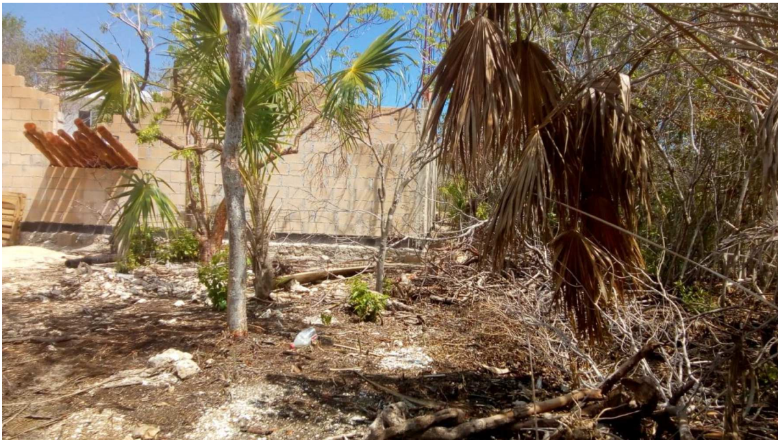
Figura .9. Topografía plana e hidrología superficial con escurrimientos menores hacia el Este. Al fondo se observa una obra en construcción colindante al proyecto, que afectan indirectamente el predio objeto de este estudio.
