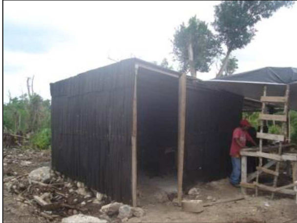
Figura 19: Bodega de estructura de madera con polines y recubierta con láminas de cartón petroleadas
