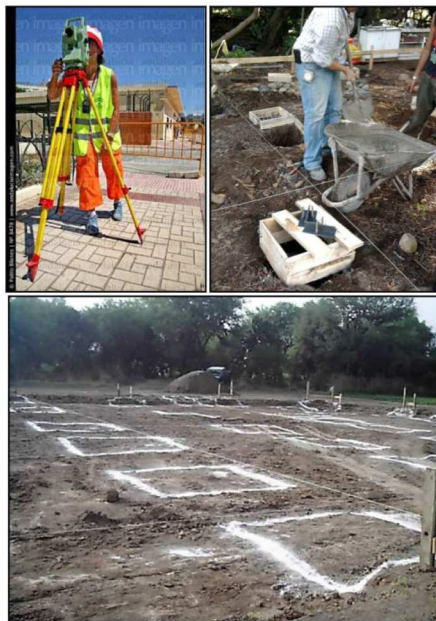
Figura 22: Proceso de nivelación y trazo de obra.
