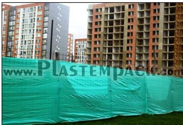
Figura 11: Colocación de malla de plástico, para delimitar el área de trabajo de obra
