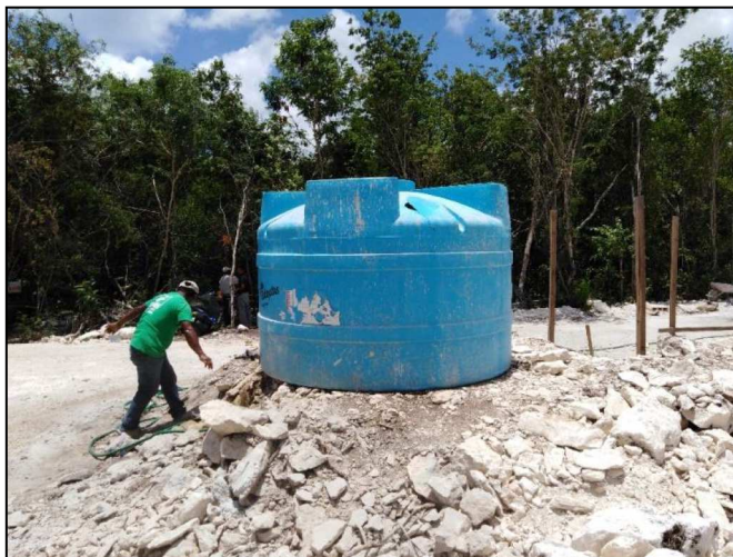
Figura 20: Se colocará una cisterna industrial para almacenar el agua potable, la cual servirá en la etapa constructiva del proyecto. La capacidad de almacenamiento será de 5,000 litros.
