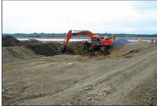
Imagen No. 26. Esta imagen ejemplifica la formación de bordos perimetrales usando el mismo material producto de la nivelación (despalme).
