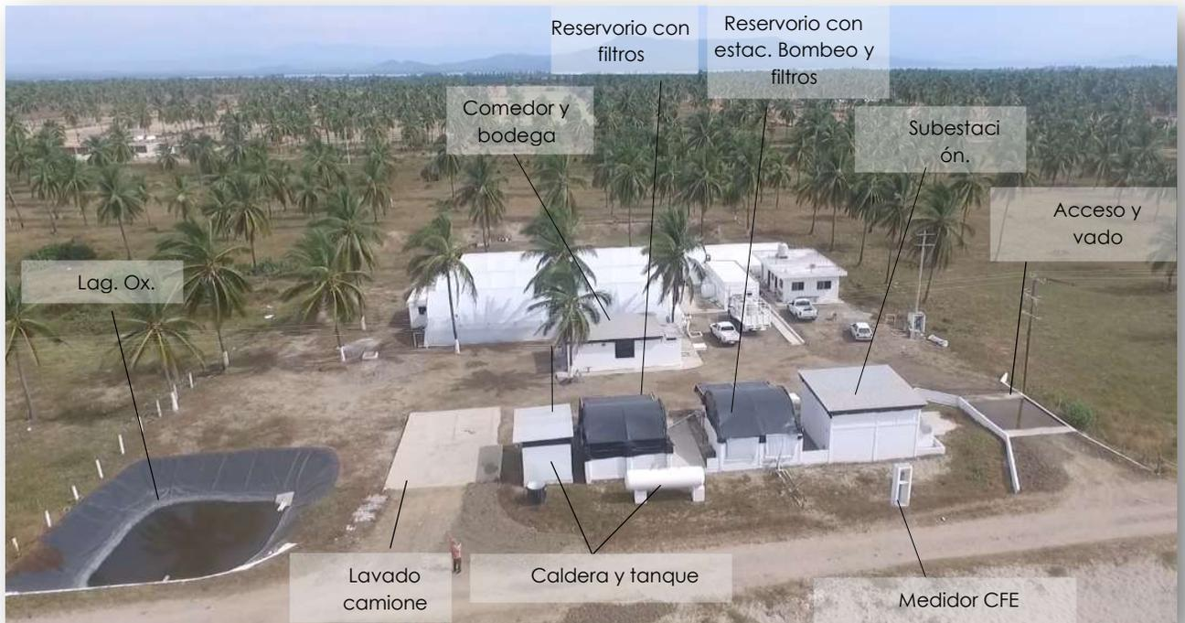
Zona federal y terrenos ganados al mar con las instalaciones hidráulicas y de descarga final.
