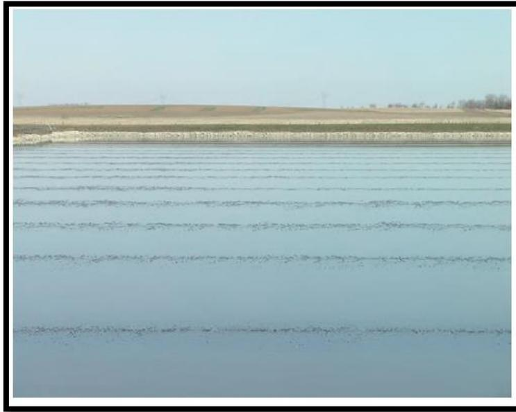
Figura VI.1. Disposición de aireación por del ADS en estructuras acuáticas para el tratamiento de efluentes
