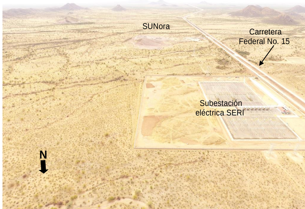
Vista panorámica al sitio del proyecto, ubicado al sur de la Subestación eléctrica SERI, la zona es semiplana.
