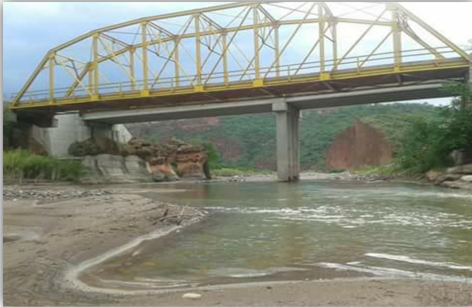
Puente Río Atenco
