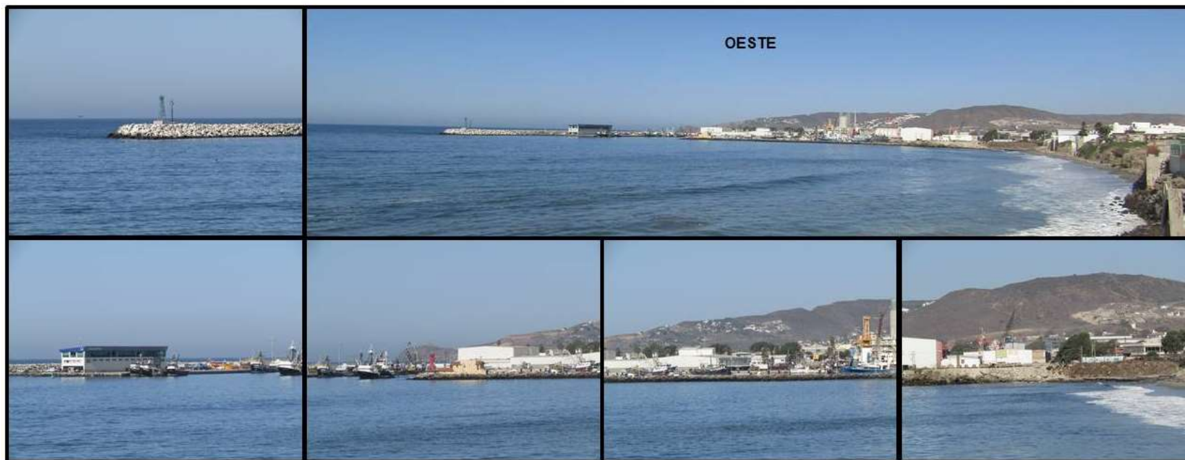
Vista panorámica hacia el Recinto Portuario El Sauzal, se muestran algunos acercamientos.
