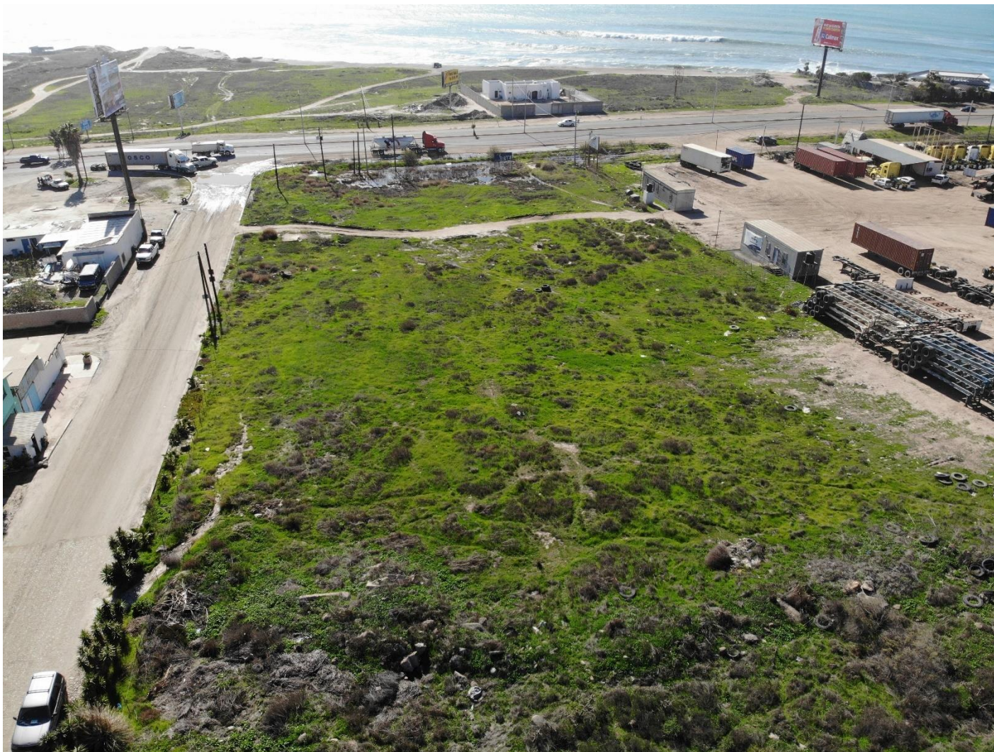
Figura LVIII. ANEXO CARTOGRÁFICO: Vista aérea del predio, en donde se observa al fondo la Carretera Tijuana-Ensenada. Es posible observar la localización del proyecto dentro de un entorno urbano e impactado.
