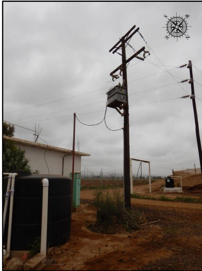
Foto 8. Subestación eléctrica que alimenta a la planta desaladora.
