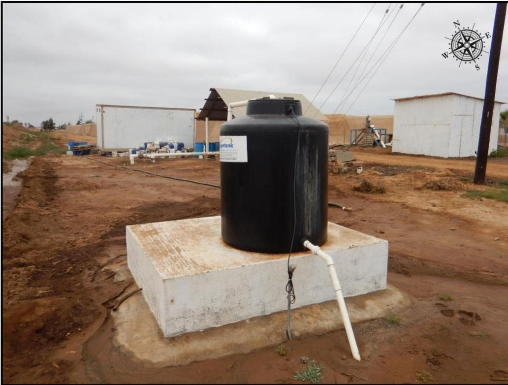
**Foto 20.** Tanque para agua de rechazo con capacidad de almacenamiento de 2,000 litros y base de cemento.
