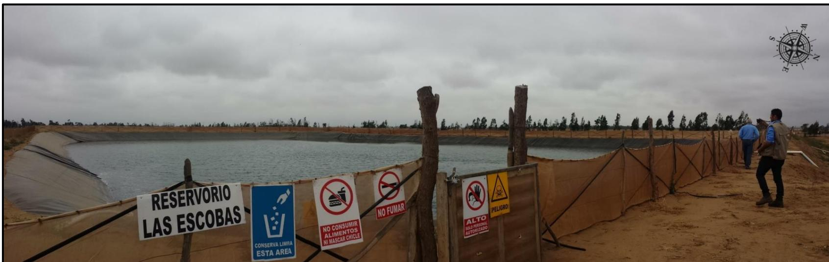
**Foto 21.** Vista del reservorio de agua producto con dimensiones de 90m x 60m x 5m, capacidad de 36,000 m<sup>3</sup> aprox. Tanto el reservorio de agua producto como de agua de mezcla ya se encontraban construidos, para integrarlos al proyecto fue necesario acondicionarlos con una membrana plástica en el fondo.
