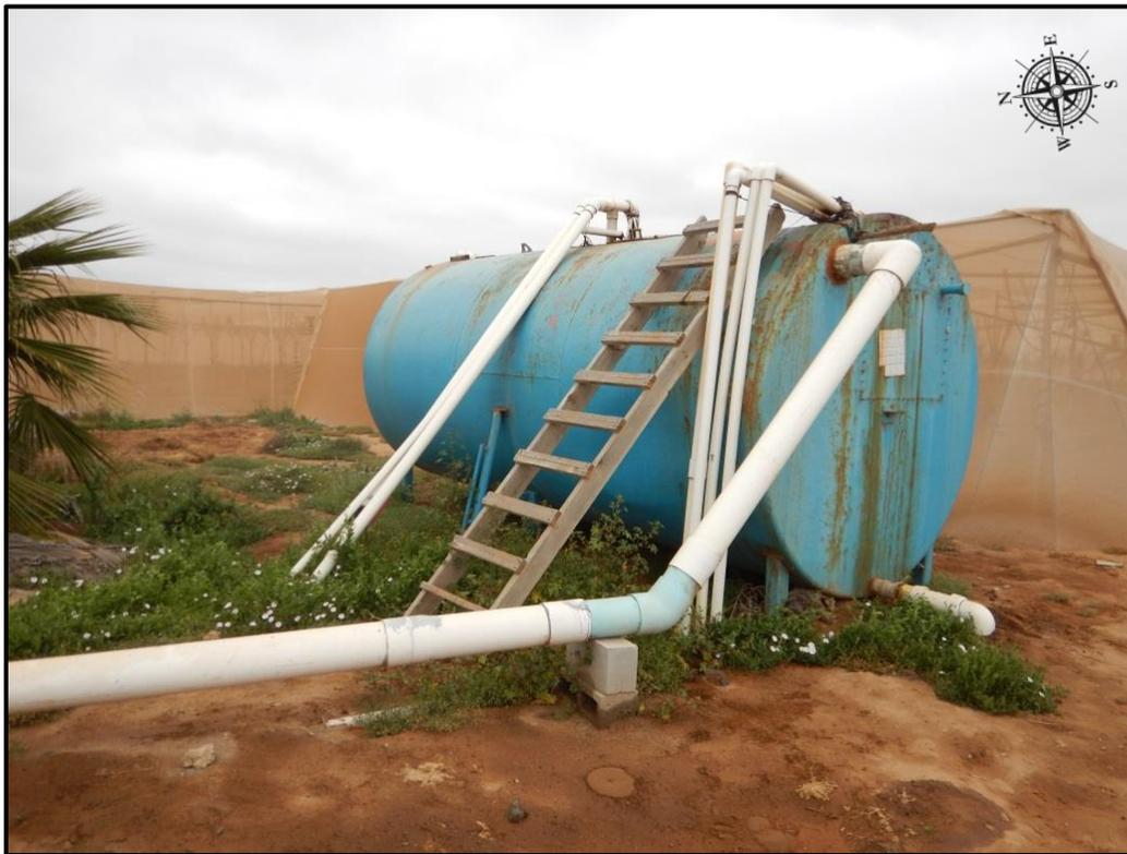
Foto 6. Tanque para recepción de agua de pozo.
