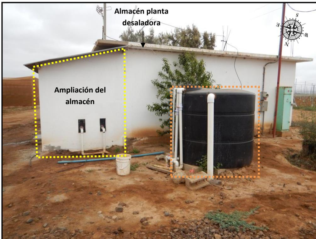
Foto 13. Tanque para mezcla de agua de rechazo del módulo 1 y pozo (polígono naranja) con capacidad de 4,000 litros. También se observa la ampliación del almacén de la desaladora (polígono amarillo).
