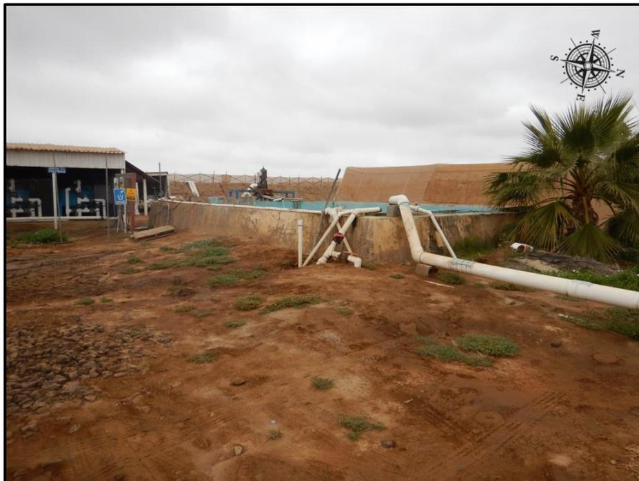
Foto 7. Pila que actualmente es usada para la mezcla de pozo y de agua producto.
