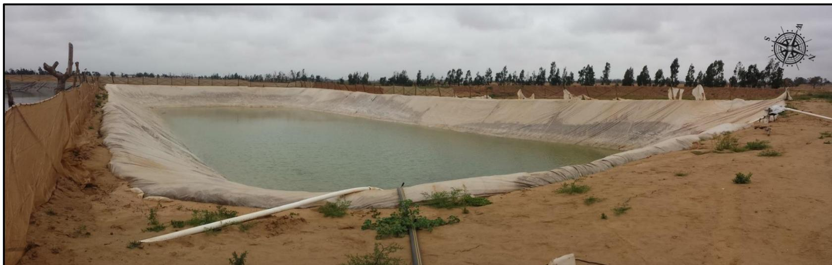
**Foto 22.** Vista actual del reservorio de almacenamiento de agua de rechazo, con dimensiones de 90m x 30m x 5m, capacidad de 18,000 m<sup>3</sup> aprox.
