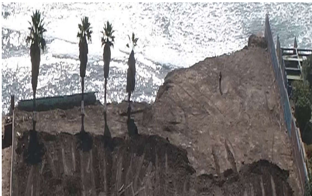
Fotografía No. 1.- Orientación Norte-Sur.
