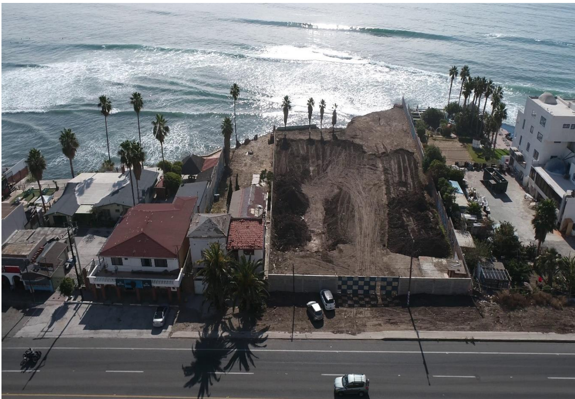
Fotografía No. 6.- Orientación Norte-Sur
