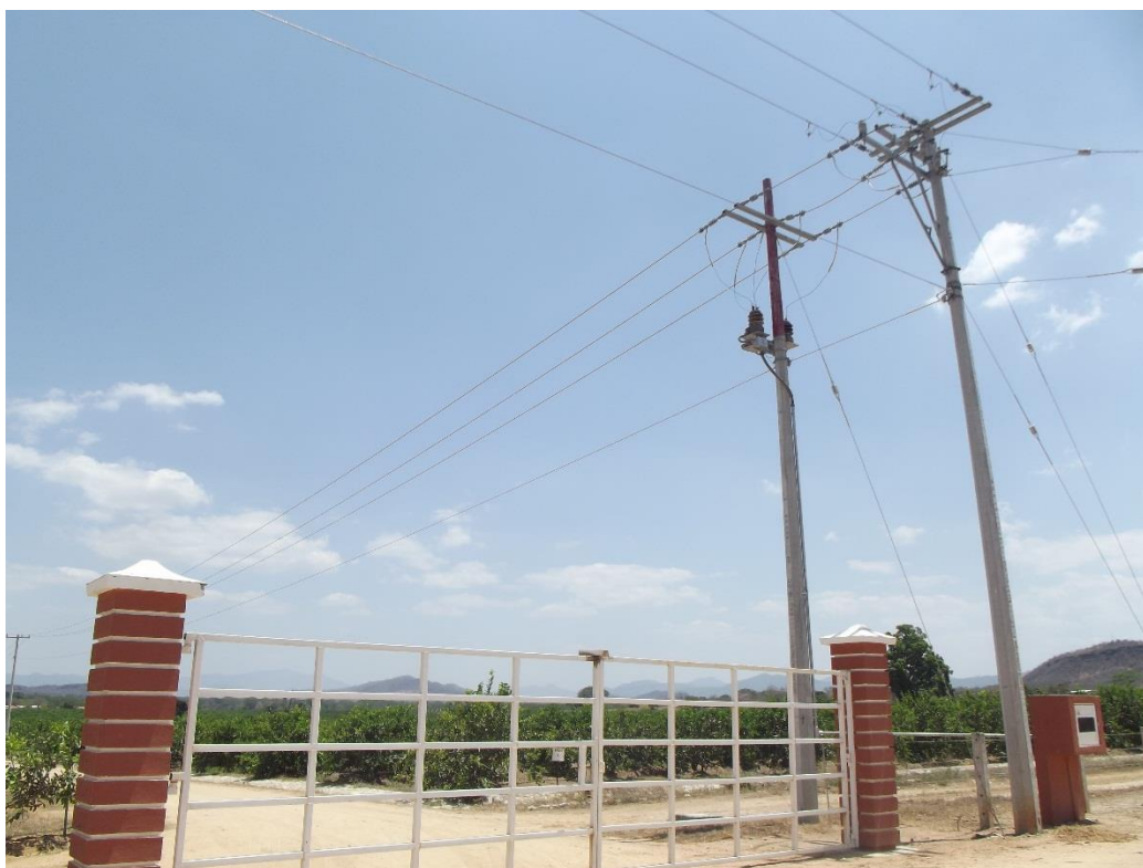
Foto 1.- Portón de acceso al predio del proyecto, donde se observa la línea de conducción eléctrica para la operatividad de las bombas de agua del sistema de riego.
