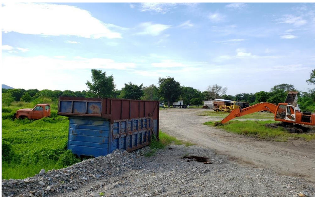
Imagen 2.2 Imagen del Predio donde se ocuparán espacios para el desarrollo de las actividades del proyecto, cabe mencionar que derivado a que el promovente del proyecto se dedica a la renta de maquinaria y equipo, en el sitio del proyecto se encuentran algunas máquinas y vehículos que son rentados para trabajos de construcción.
