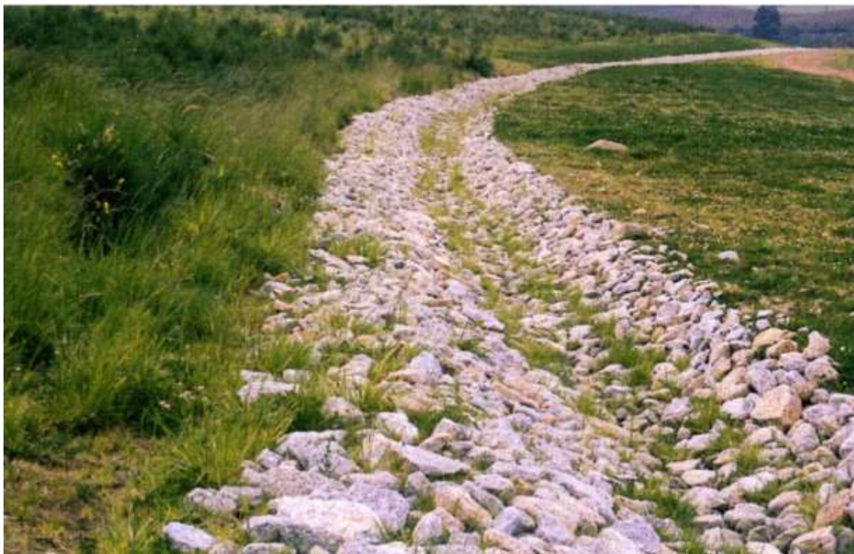
Imagen ilustrativa del Canal o drenaje óxico calizo
