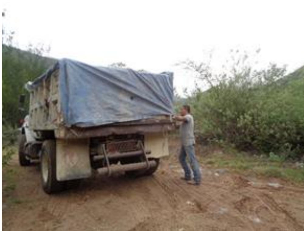
Figura II-7. Colocación de lonas a los camiones de carga para el transporte del material
