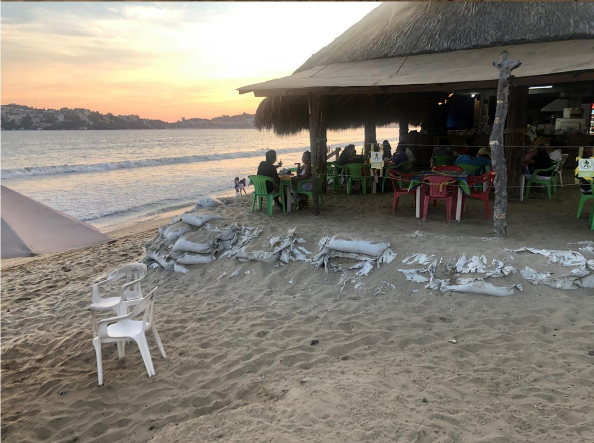
Esta erosión puede afectar las estructuras del Restaurante-Bar si No se llevan a cabo medidas de protección, por tal motivo se propone la instalación de estructuras tipo gavión con piedra acomodada para permitir el libre flujo hídrico en la zona y darle reforzamiento a la estructura del Restaurante-Bar.
