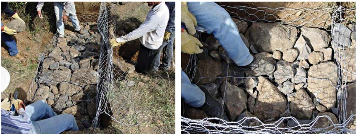
Figura II.14. Tensores entre paredes de gaviones.
