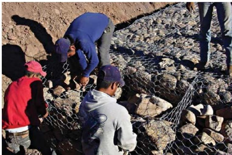
Figura II.16. Unión de gaviones llenos de piedra.
