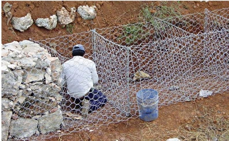
Figura II.12. Gaviones en la zanja.
