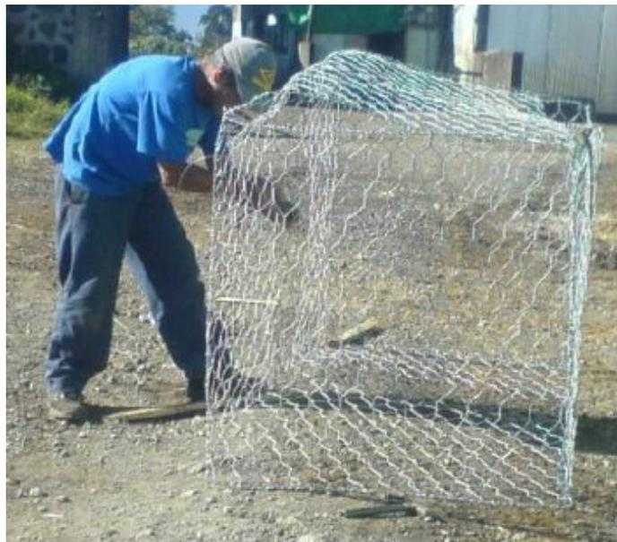
Figura II.10. Armado de gaviones unidos con alambre.
