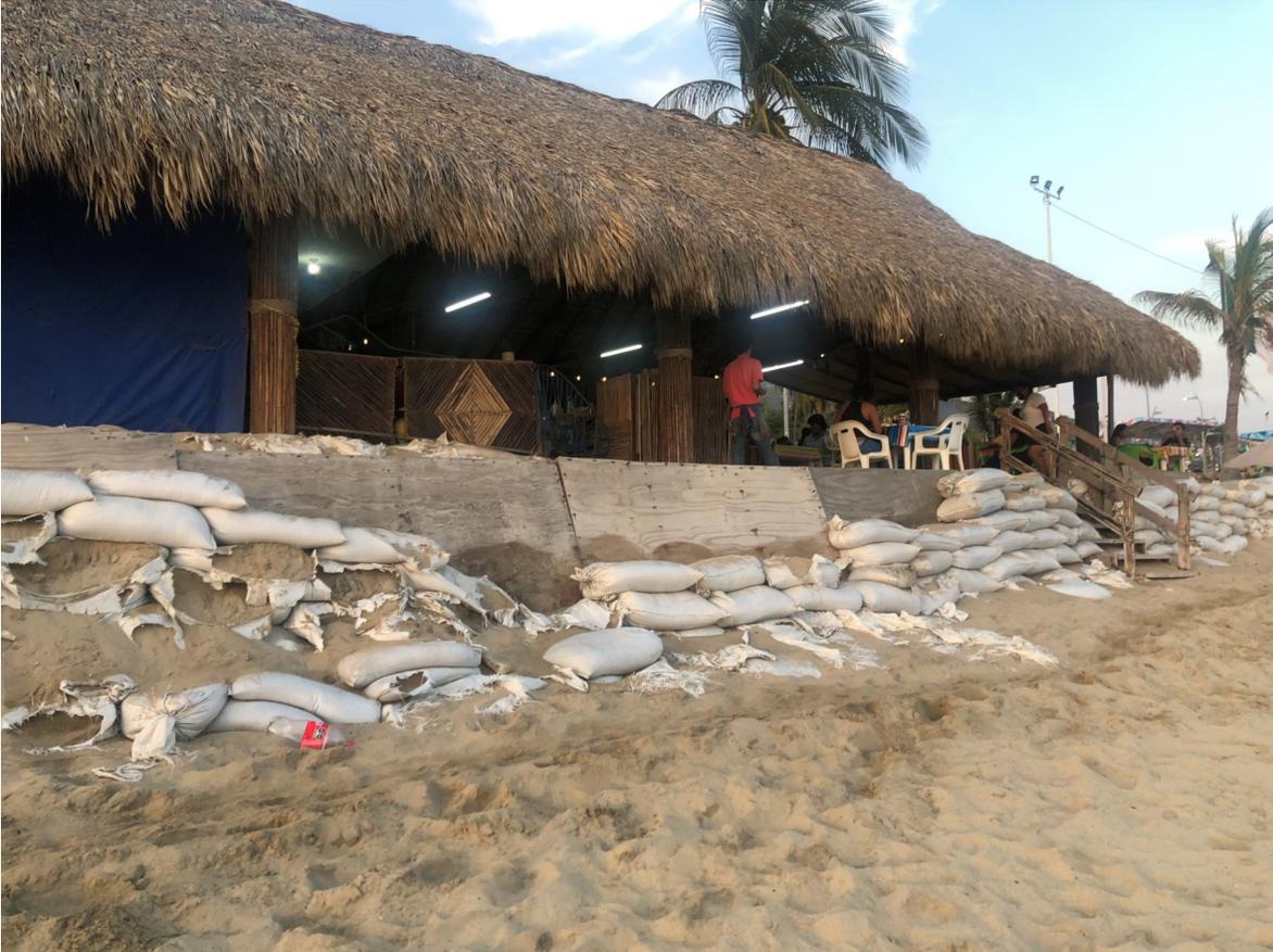
Figura II.3. Imágenes de la erosión actual en las instalaciones del Restaurante-Bar, en la Zona Federal Marítimo Terrestre.
