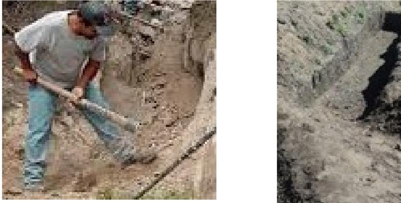
Figura II.8. Realización de zanjas para la cimentación y/o empotramiento del muro gavión.
