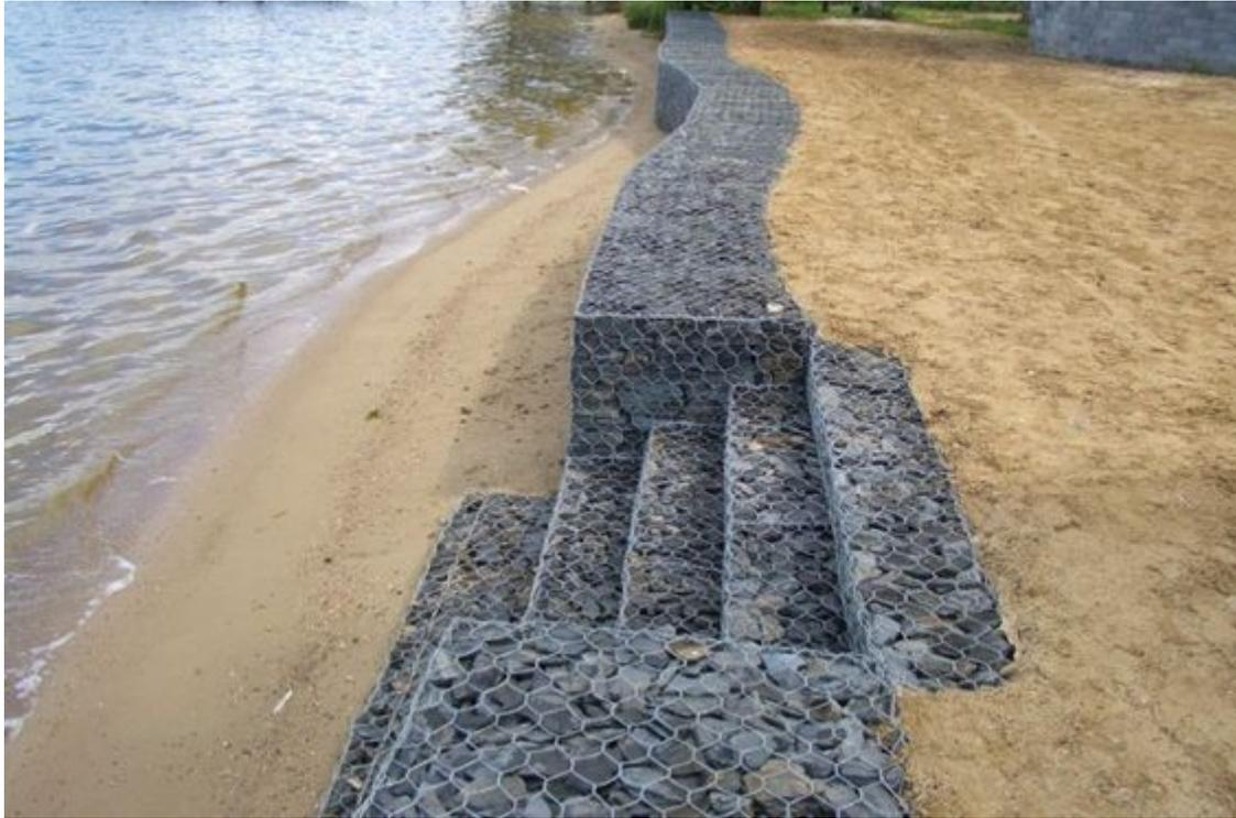
Figura II.4. imagen representativa del muro gavión a utilizarse en el Restaurante Bar Mi Vereda Tropical, en la Zona Federal Marítimo Terrestre.
