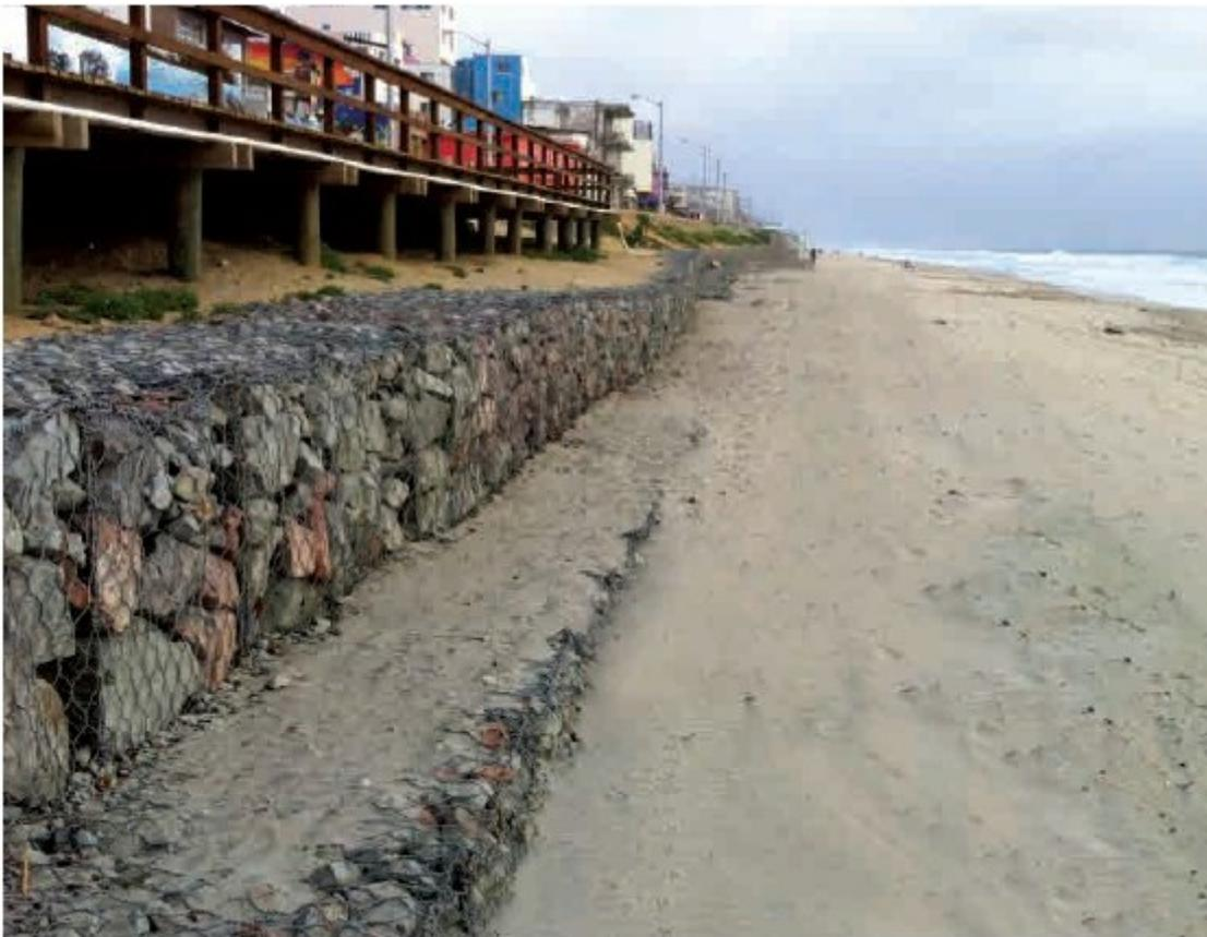
Figura II.7. Altura de un muro de gavión en playa, con la finalidad de proteger una estructura de la erosión causada por el mar.
