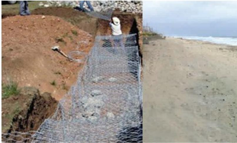
Figura II.11. Colocación de gaviones.
