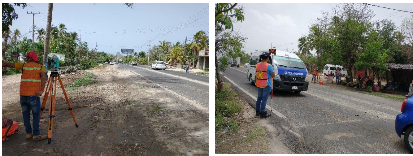
Fig. 8.- Dentro del levantamiento topográfico de la línea de conducción se identificaron y levantaron los cruces de líneas entre los pozos, con el mismo procedimiento y equipo de estación total.
