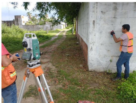
Figs. 6, levantamiento topográfico de la zona de captación
