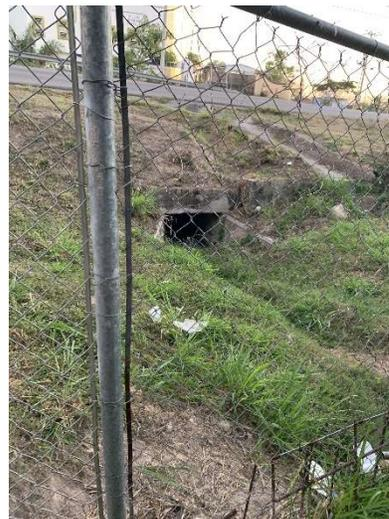
**Fig. IV.31** Se aprecia la alcantarilla construida para el cruce del escurrimiento temporal en la carretera Federal 200 como se puede observar no lleva agua.
