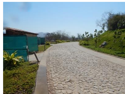
Colindancia suroeste del predio donde se ubica la Vialidad 1.
