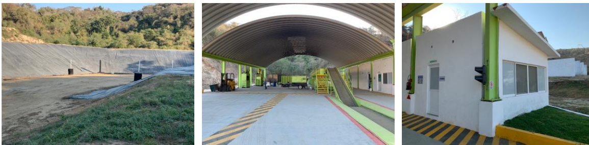
Figura 21. Vistas de las nuevas instalaciones del Relleno Sanitario “Los Brasiles”
