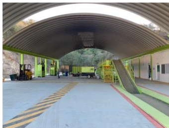
Planta de separación y compactación de plásticos
