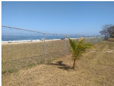
Colindancia poniente del predio donde se observa el área de los TGM.
