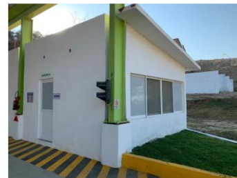
Oficinas administrativas de las nuevas instalaciones
