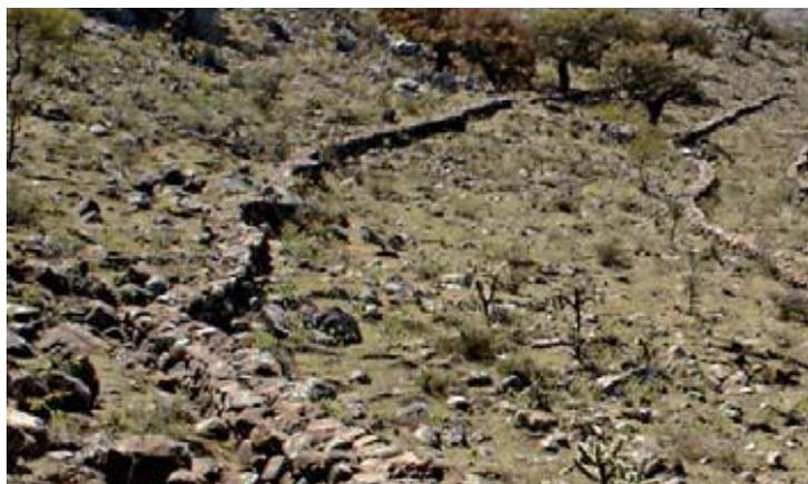
Dichas terrazas (Ramas y Costales) se construyen colocando ramas y/o costales de tal manera que se forme una barrera cuadrangular de 50 centímetros de alto por 50 centímetros de grosor. La obra servirá para disminuir la velocidad de escurrimiento en terrenos de ladera, coadyuvar al establecimiento de vegetación forestal, retención de suelos y propiciar la infiltración de agua. Las
