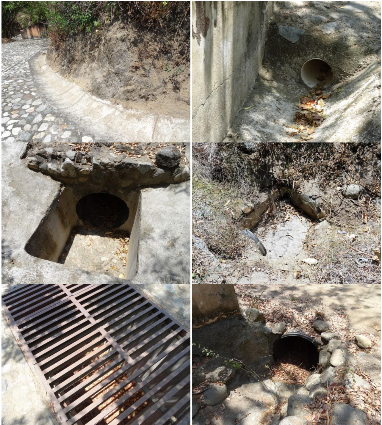
Figura VI-6. Obras construidas en el terreno para el manejo de escurrimientos pluviales (actuadas por PROFEPA)
