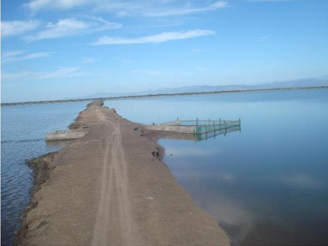
Compuerta de alimentación de agua del estanque dos al estanque uno de la granja, el bordo que delimita el estanque dos del estanque uno presenta un ancho mínimo que requiere rehabilitación.
