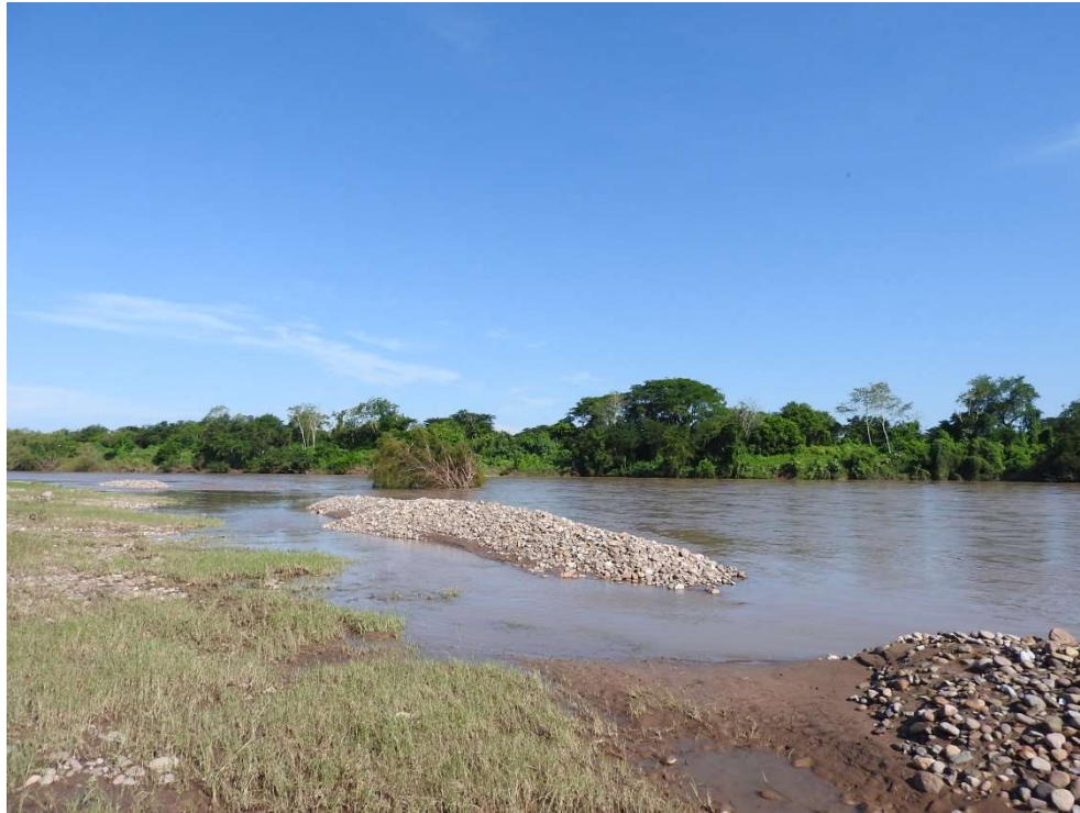
VISTA DEL KM 1+560 KM 1+880
