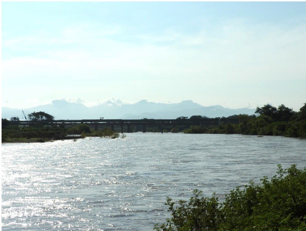
VISTA DEL KM 0+000 KM 0+340
