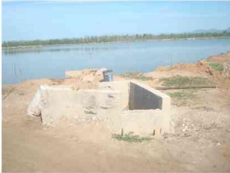
Compuerta de alimentación del estanque de la granja, se abastece del cárcamo de bombeo, la presencia de vegetación halófila en los bordos estabiliza y contrarrestan el efecto de erosión que genera el movimiento del agua.
