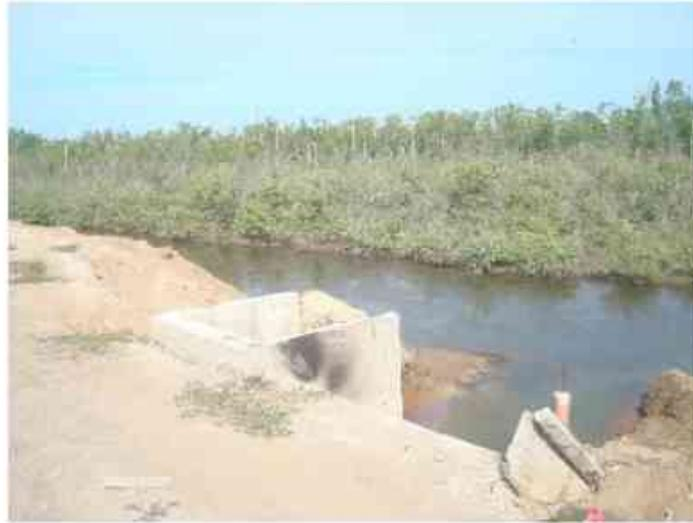
Compuerta de salida del estanque de engorda de la granja, parcialmente se aprecia la condición de la bordería erosionada, se prevé el establecimiento inducido con mangle para estabilizar y conservación del talud del bordo y aporte al hábitat de especies silvestres.
