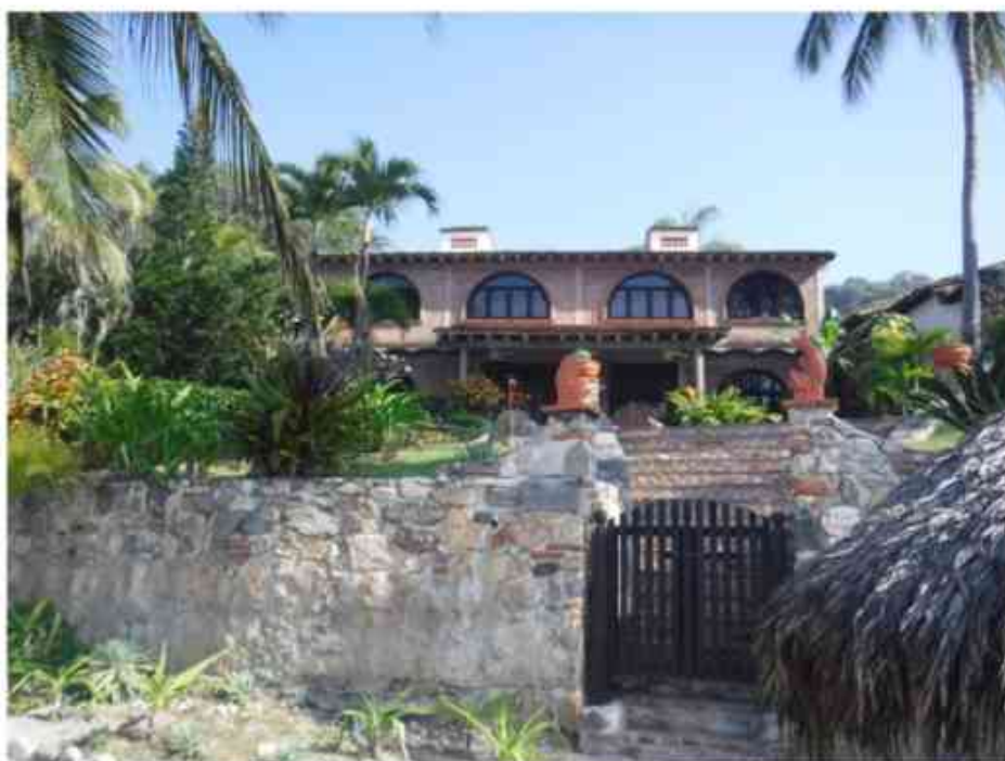
FIGURA II. 1 CASA EXISTENTE EN EL PREDIO
