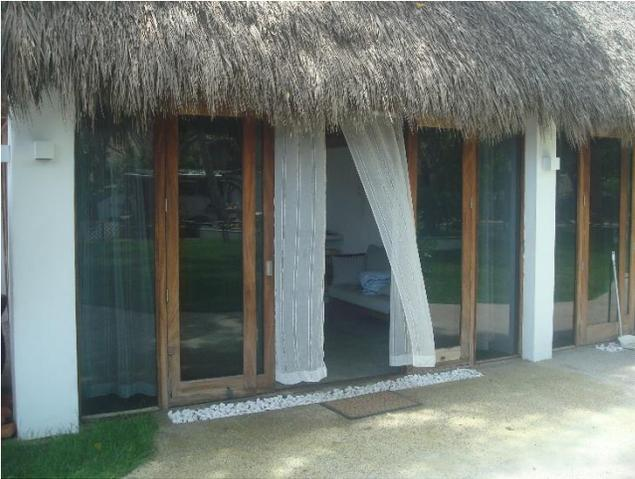
Cuartos o Habitaciones del Proyecto, construidas de madera de la región con paredes de tabla roca, con techo de palapa y subdivida con un tapanco cada una, con puertas corredizas de vidrio y madera.
