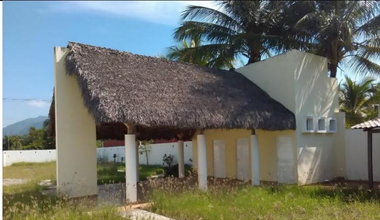
*dos baños y una bodega en aproximadamente 14 metros cuadrados, con techo de concreto armado paredes de block con enjarre de mortero, piso cerámico*
