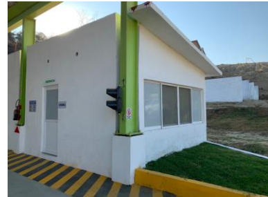
Oficinas administrativas de las nuevas instalaciones
