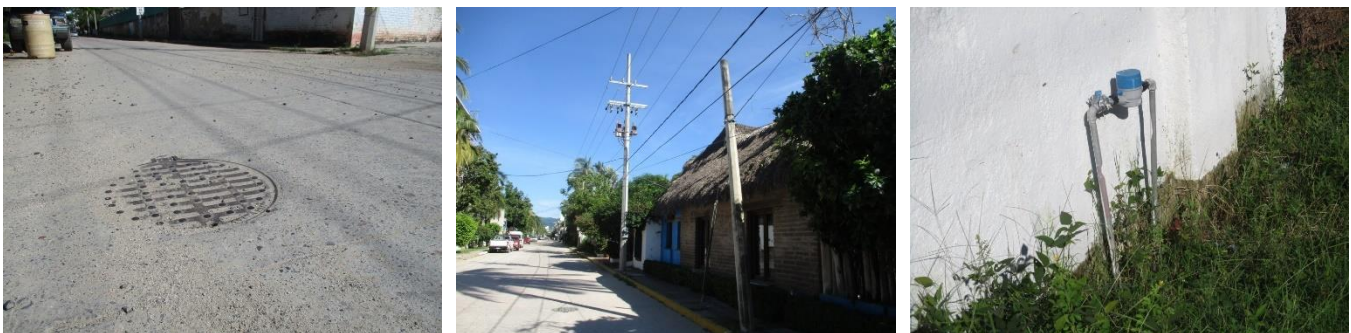
Figura 16. Infraestructura localizada al pie del lote para el suministro de los servicios al proyecto
