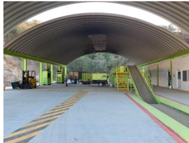
Planta de separación y compactación de plásticos
