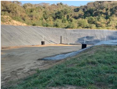
Nueva celda con geomembrana para la disposición final de los residuos
