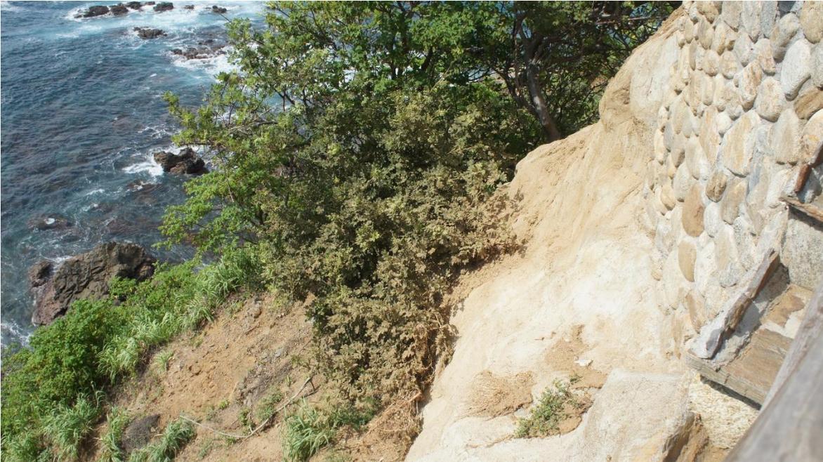
**Imagen XI.-** área definida como afectada en la Zona Federal Marítimo Terrestre, donde se aprecia el deslizamiento de tierra por las actividades de remodelación de la cabaña 1.
