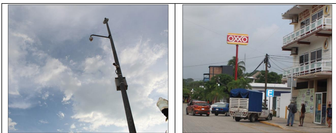
Figura II.6- Cámaras de vigilancia y energía eléctrica existentes en la zona del proyecto.
