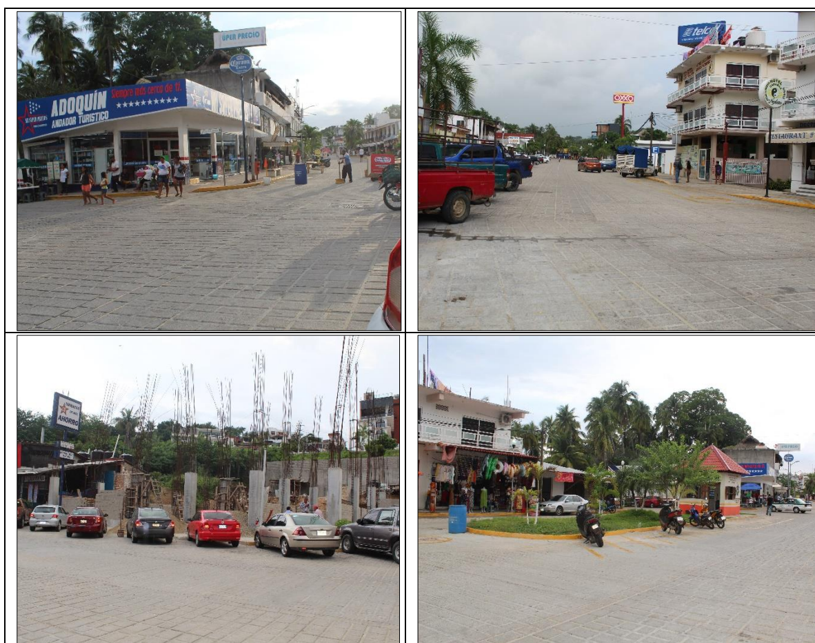
Figura II.4- Vías de acceso bien delimitas y pavimentadas, se puede observar la urbanización existente.
